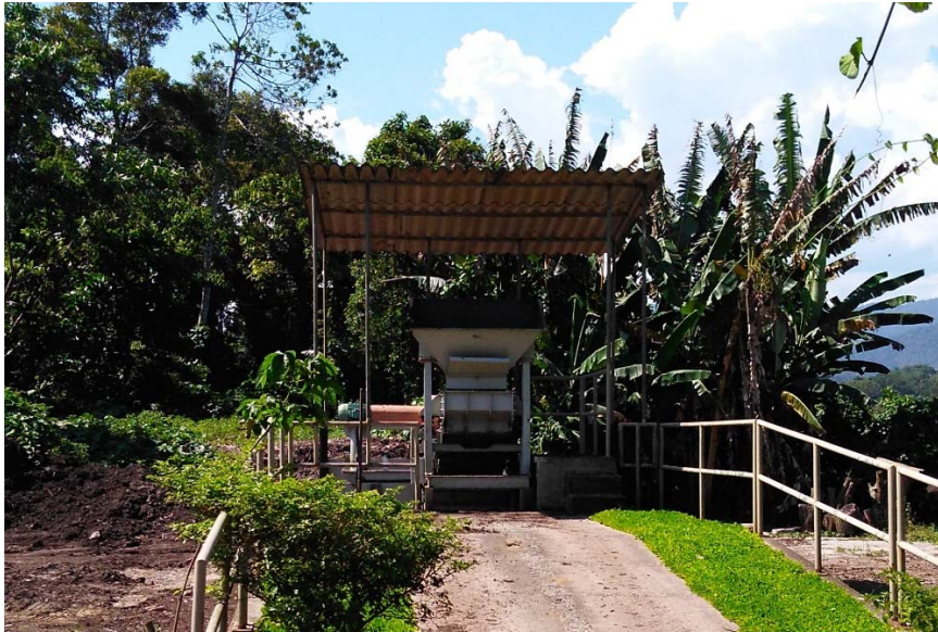
Galpão que abriga o peneirador de resíduos
